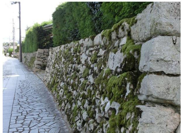
このため、現場では一つひとつの石の個性を判断しながら積む必要があり、設計図では表現できない臨機応変な対応が求められます。
